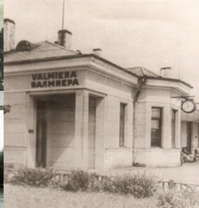
Valmieras dzelzceļa stacija, 1961. gads
