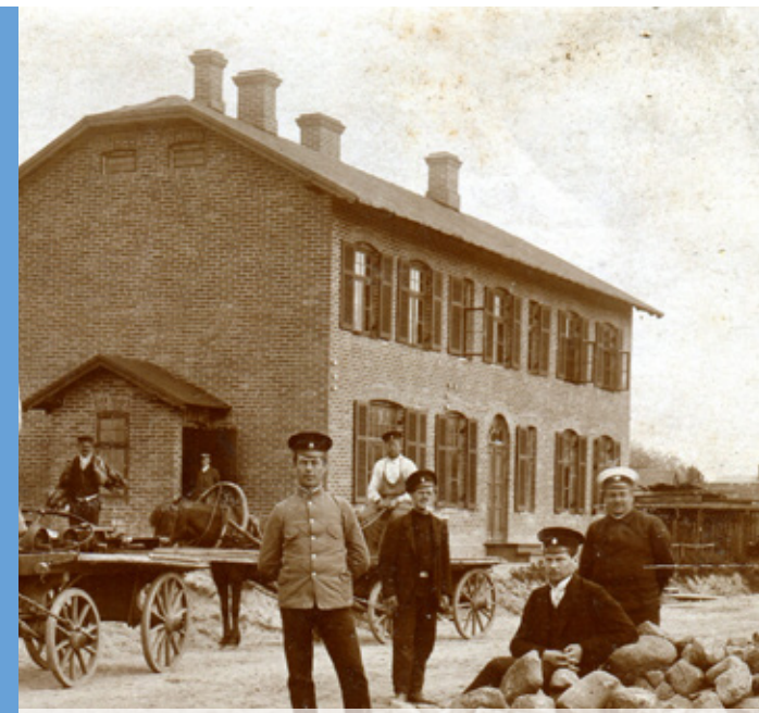
Šaursliežu dzelzceļa līnijas Smiltene – Valmiera dzelzceļa administrācijas ēkas celtniecība Marijas ielā, 1910. gads
