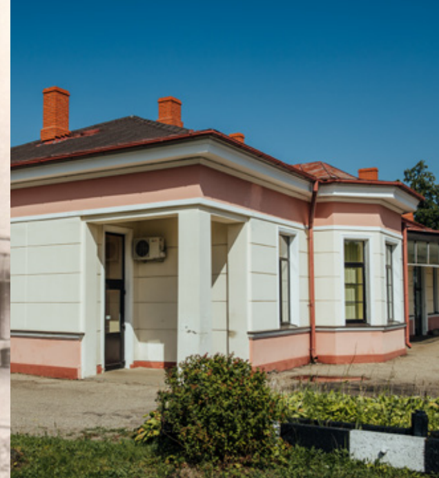
Valmieras dzelzceļa stacija, 2022. gads
